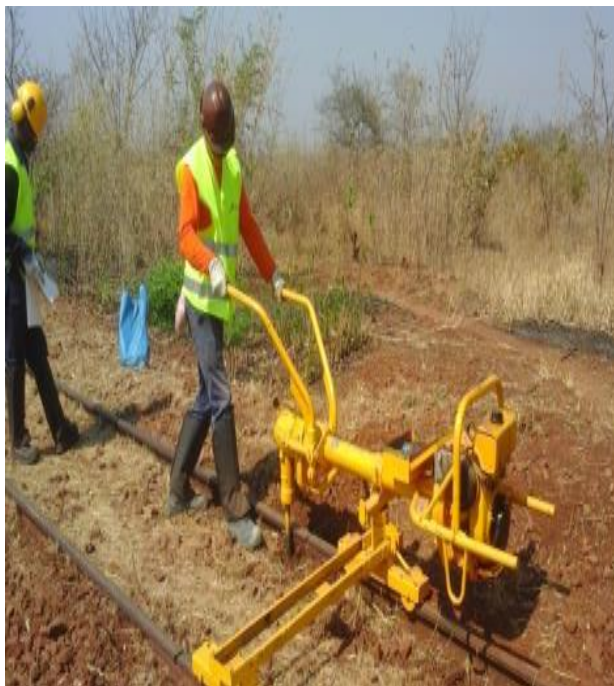
PROCESSO DE ASSENTAMENTO DE VIA - RECOLHA DE TRAVESSAS E AFASTAMENTOS DE CARRIS
