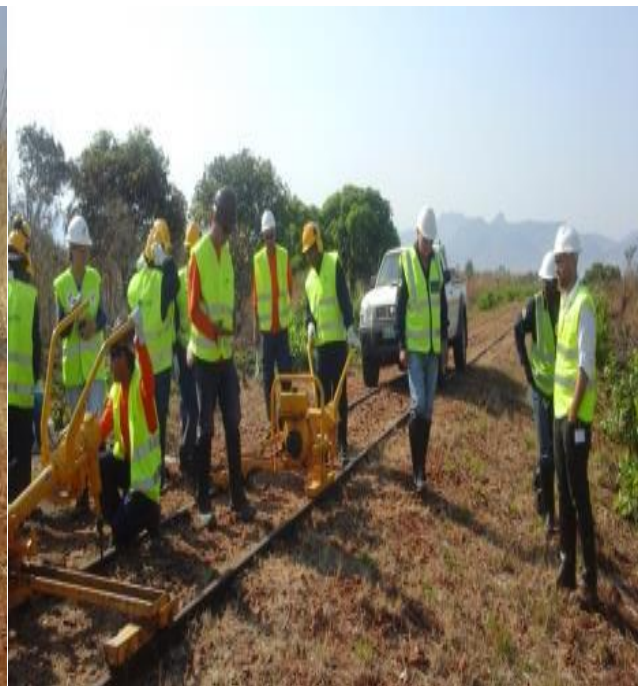
PROCESSO DE ASSENTAMENTO DE VIA - RECOLHA DE TRAVESSAS E AFASTAMENTOS DE CARRIS
