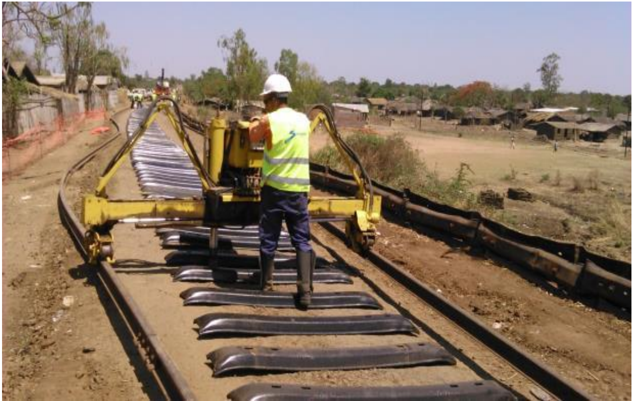
TRABALHOS DE ASSENTAMENTO DA LINHA CUAMBA – LICHINGA, APÓS O NIVELAMENTO DA PLATAFORMA
