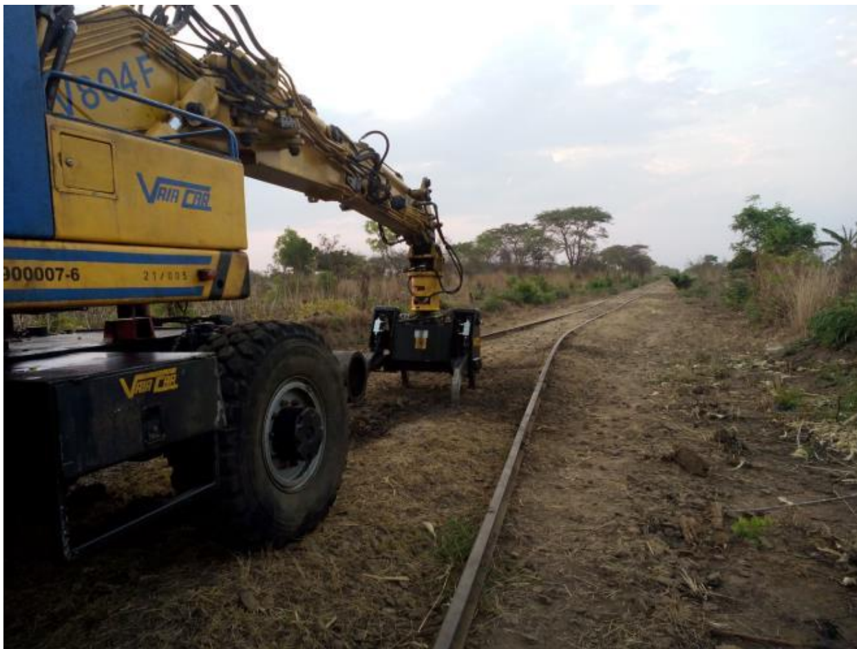
PROCESSO DE ASSENTAMENTO DE VIA - RECOLHA DE TRAVESSAS E AFASTAMENTOS DE CARRIS
