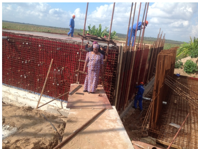
Construção de sistema de abastecimento de água
